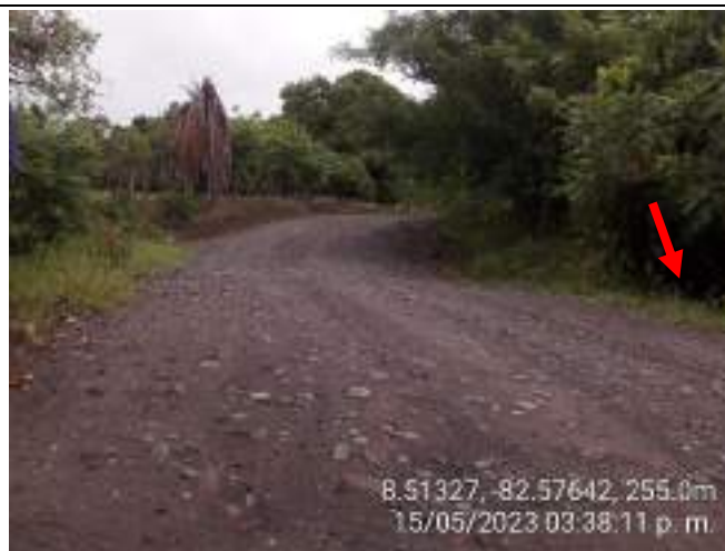
Cruce pluvial en vía existente.
