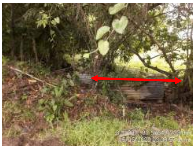
Vista aguas arriba de sección de entrada. Ancho de sección: 4.60m, en el limite de propiedad (cerca de púas).
