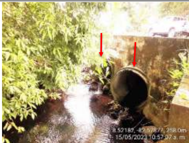
Vista de cabezal de 6.0m de ancho, 2.30m de altura y tuberías de 1.20m Ø a la salida.
