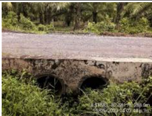
Vista de la entrada de tuberías de 0.60m Ø y cabezal de concreto. Ancho de sección: 3.60m. Sin presencia de agua.
