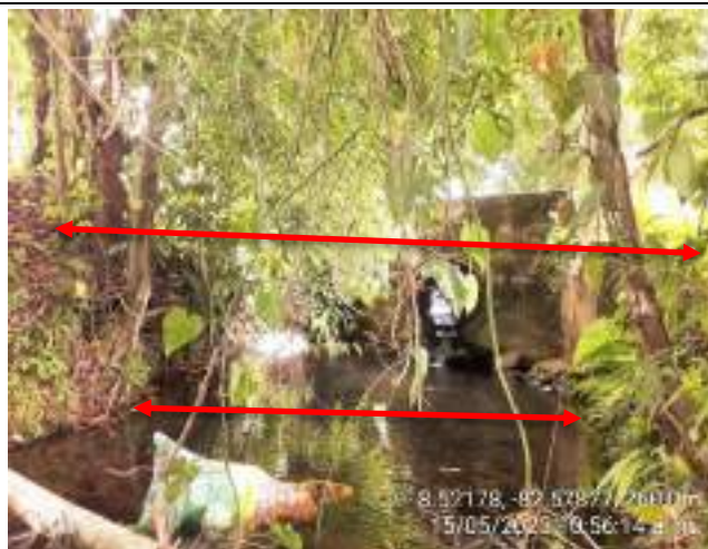
Vista del cauce justo a la salida, con ancho de sección de 4.0m y 3.60m de espejo de agua.
