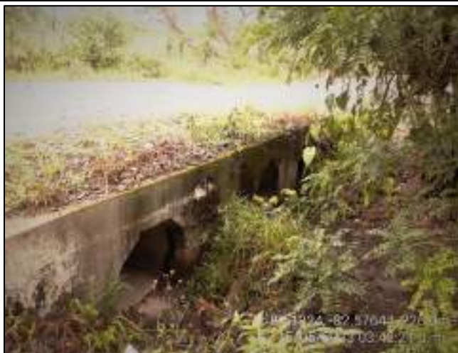
Vista de cabezal de salida y tuberías de concreto de 1.20m Ø. Ancho de sección: 6.0m próximo a la salida.
