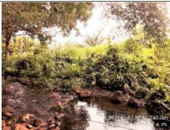
Sección de la Qda. Querengé a 120m aprox. Aguas arriba del de la intersección con la vía. Ancho de sección de 8.06m, 3.34m de espejo de agua y 0.40m de profundidad. (Coordenadas 325793.900E y 941825.500N)
