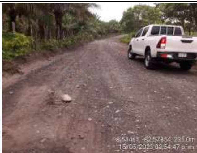
Calzada y cunetas de la vía existentes, próximo al punto 04.
