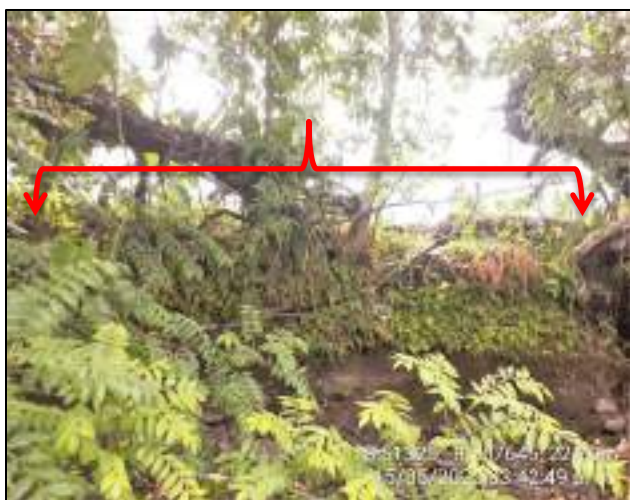
Vegetación y pared natural a la salida de las tuberías (1.60m de altura aprox.).
