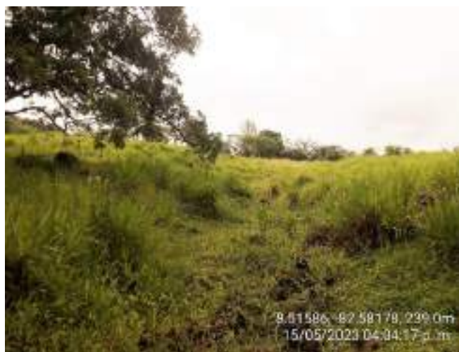
Vegetación y cauce aguas arriba del cabezal de entrada de tuberías. Sin presencia de agua como escurrimiento.
