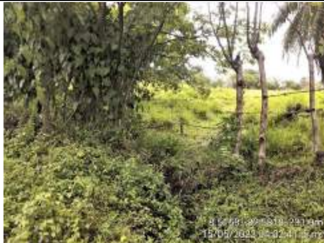
Vegetación y cauce aguas arriba del cabezal de entrada de tuberías. Sin presencia de agua como escurrimiento.
