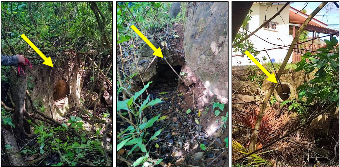
Alcantarillas de 60” y cajones que drenan agua del residenciales de Villas Del Sur, a terrenos de Brisas Del Sur
