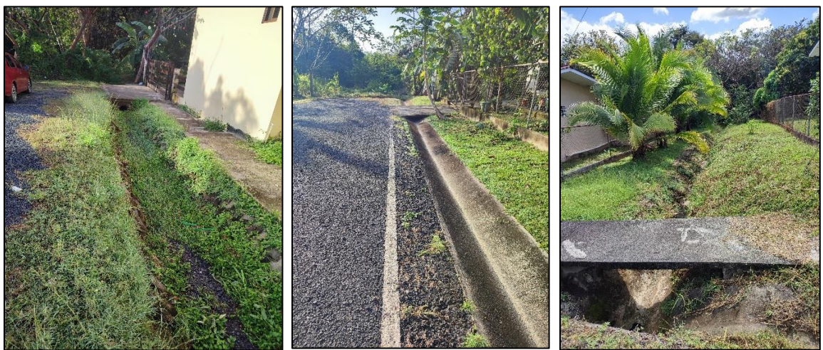
Cunetas de Villas Del Sur, que dirigen aguas de escorrentía al terreno de Brisas Del Sur
