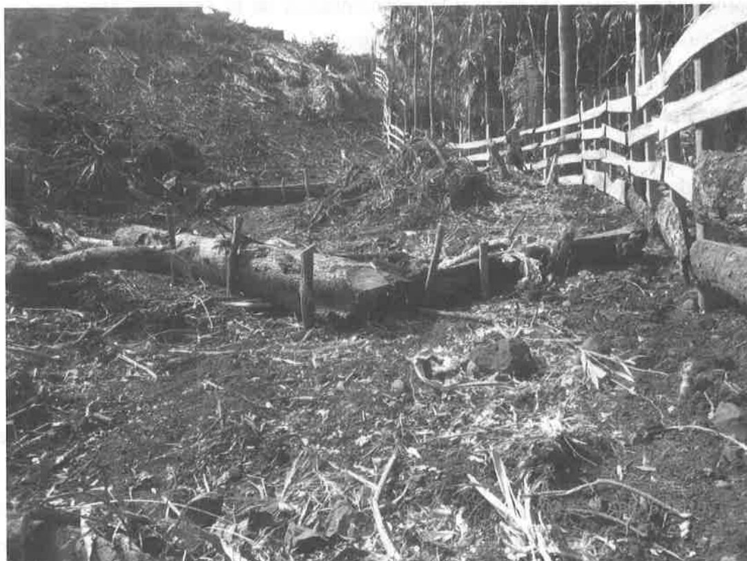
Figura 7: Barreras con material vegetal
