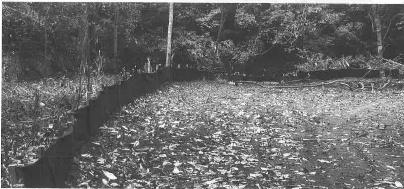
Figura 10: Barreras de geotextil
