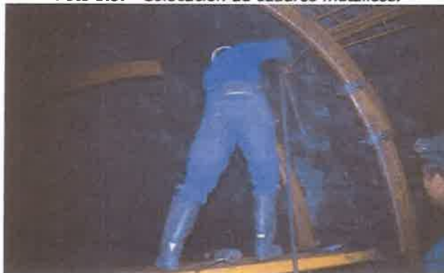
Foto 5.5. Colocación de cuadros metálicos.
