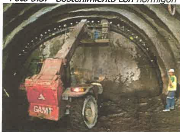
Foto 5.3. Sostenimiento con hormigón
