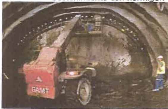
Foto 5.3. Sostenimiento con hormigón
