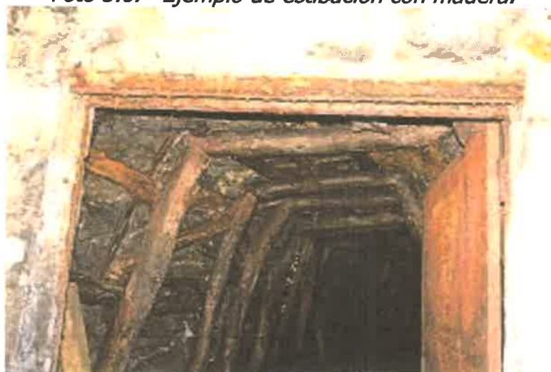
Foto 5.6. Ejemplo de estibación con madera.
