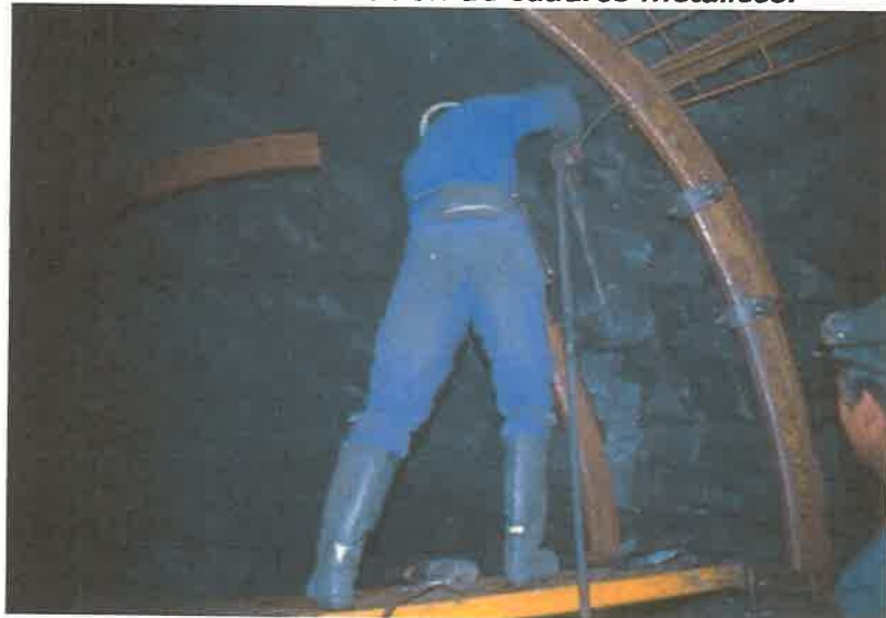
Foto 5.5. Colocación de cuadros metálicos.
