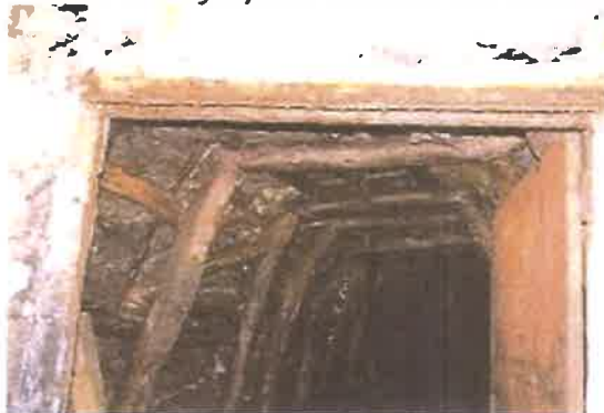
Foto 5.6. Ejemplo de estibación con madera.
