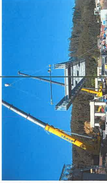
Imagen 4. Ejemplo de método constructivo de puente con izaje de elementos prefabricados mediante grúas ubicadas en las márgenes, sin afectación del cauce del río
