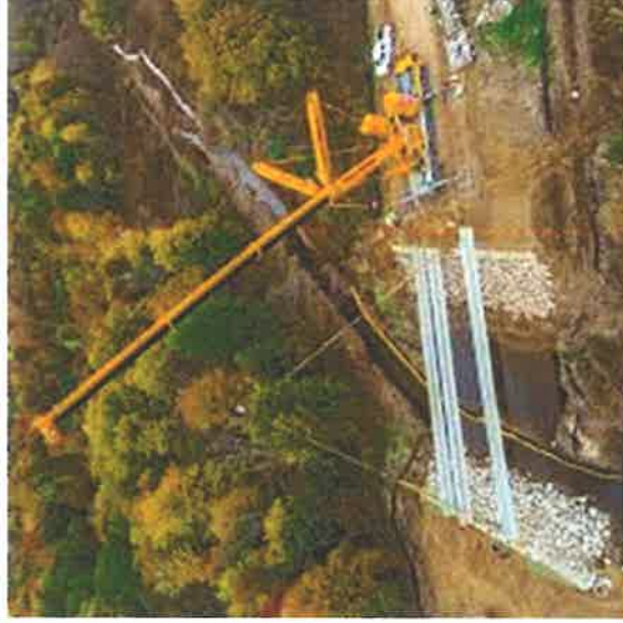
Imagen 4. Ejemplo de método constructivo de puente con izaje de elementos prefabricados mediante grúas ubicadas en las márgenes, sin afectación del cauce del río
