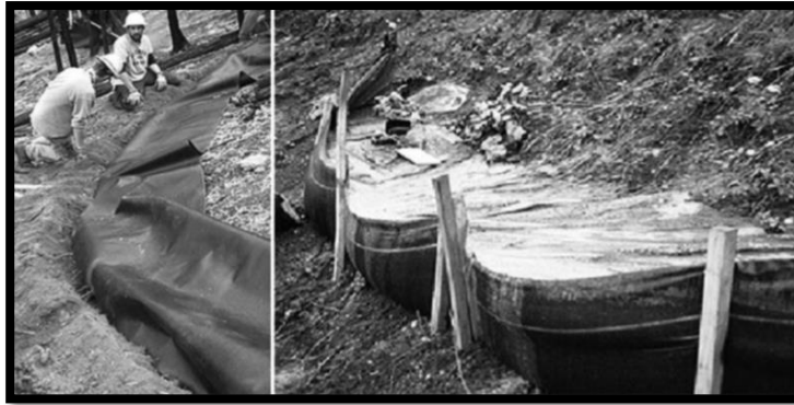
Figura 8. Colocación de mallas de limo hechas de material geotextil.
