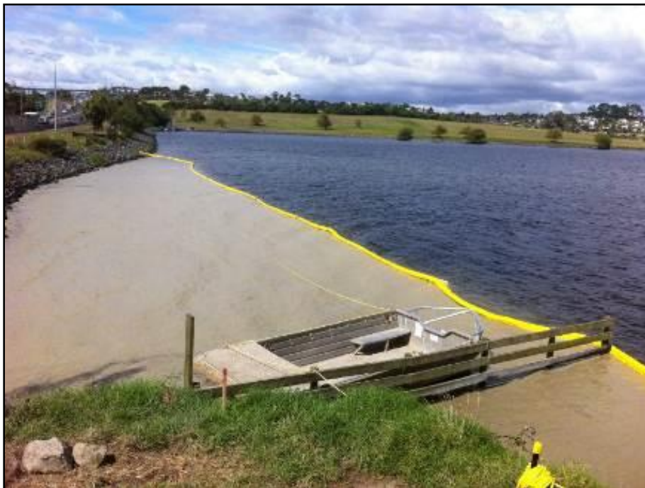
Ilustracion sobre el uso y efectividad de la cortinas flotantes.
