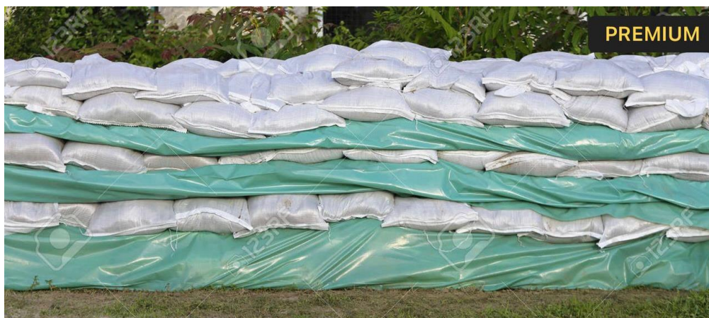
Figura 6. Ejemplo de muro de sacos de arena y lona para protección
