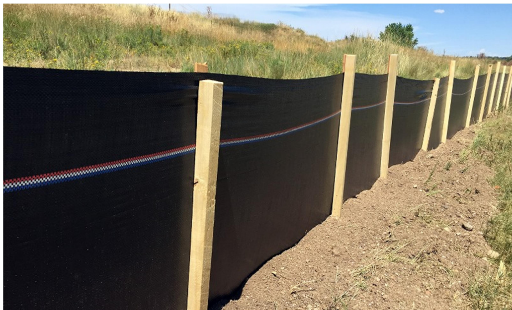
Fotografía 1 Malla para retención de sedimentos ( Silt Fence )
