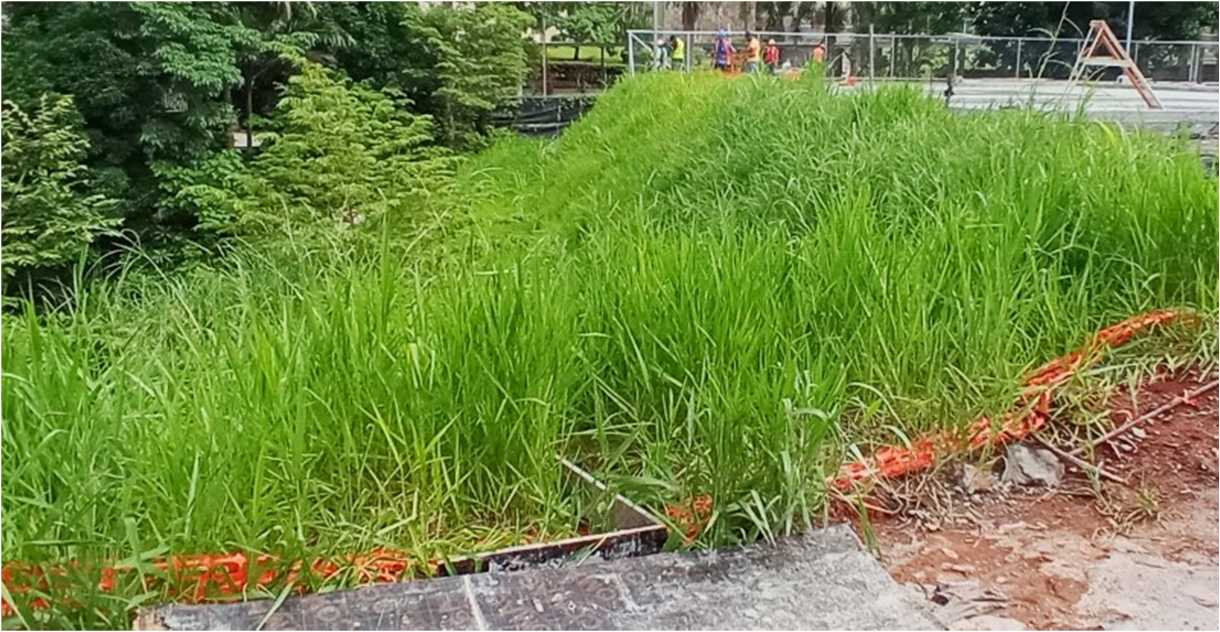
Fotografía 3 Hierbas sembradas mediante Hidrosiembra para proteger un talud
