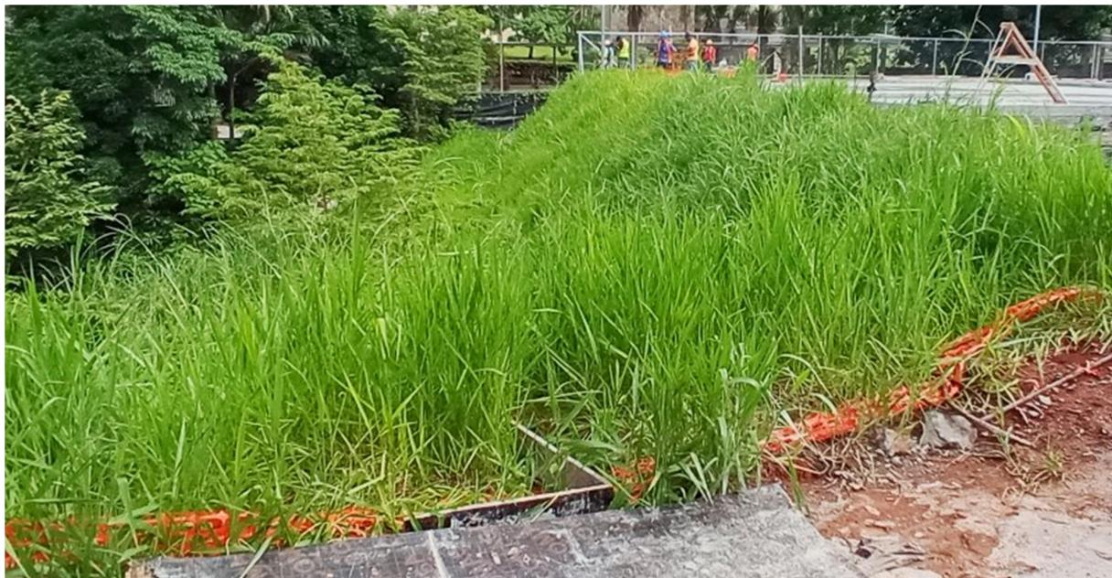
**Fotografía 2 Hierbas sembradas mediante Hidrosiembra para proteger un talud**
