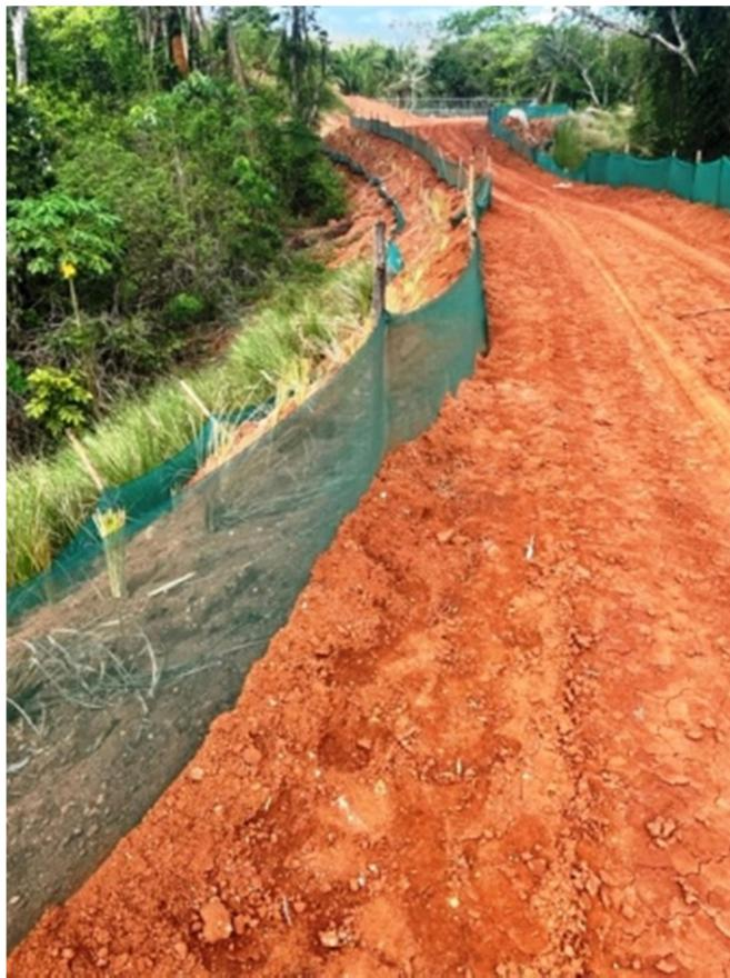
Mallas geotextiles y hierba Vetiver protegiendo un talud
