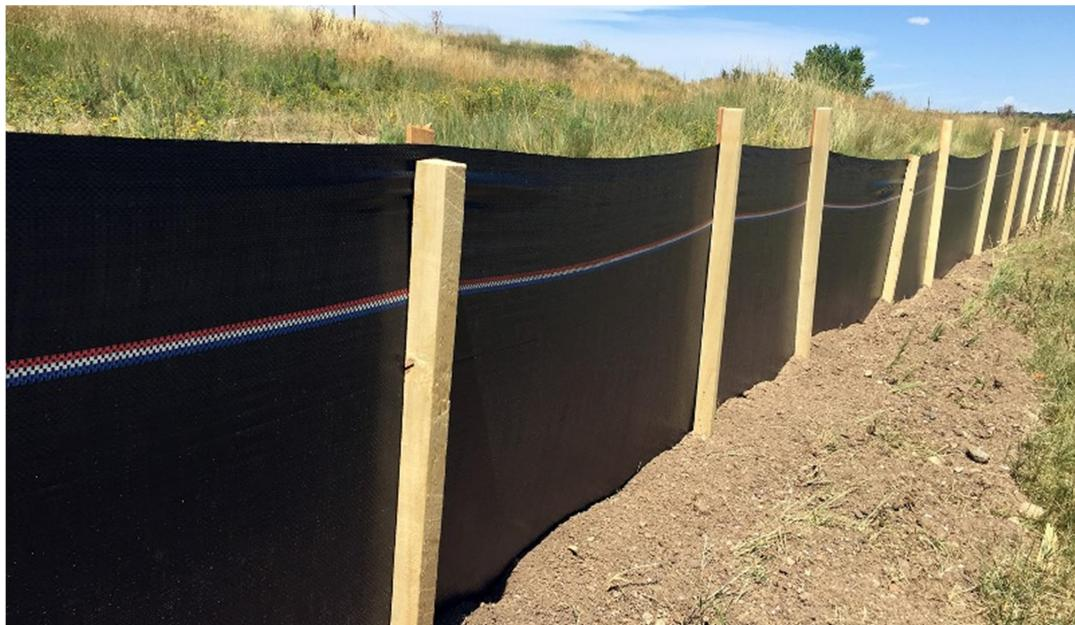
Fotografía 1 Malla para retención de sedimentos (*Silt Fence*)
