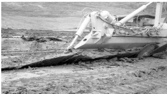
Ilustración 5-7 Huella provocada por la excavación del arado
