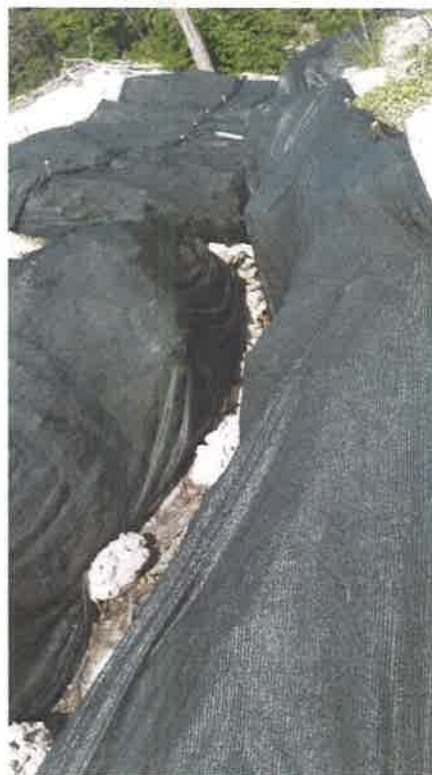
Geomanta y cordón o berma en taludes.
