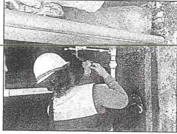
Tanque de Agua
