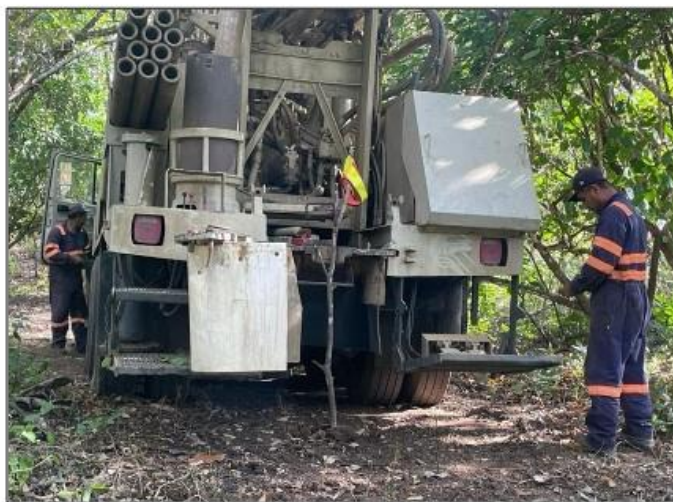
Figura 15. Ubicando del equipo en el punto detectado con geofísica, en el proceso de perforación del pozo No. 1-23. Fuente: Equipo Consultor, 2023.
