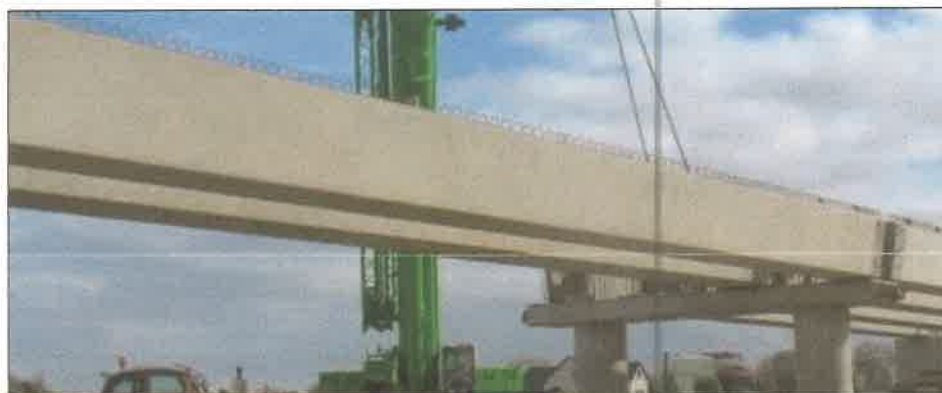
Figura 5.2.2.3. Instalación de vigas prefabricadas.
