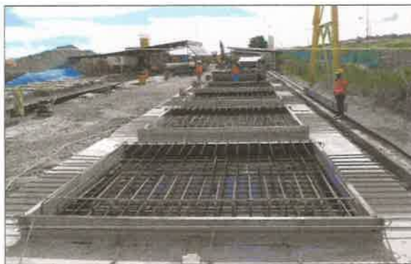
Figura 5.1.1.1. Prefabricación de estructuras en concreto, pilotes, tablestacas y estructuras metálicas
