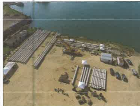
Figura 5.1.1.1. Prefabricación de estructuras en concreto, pilotes, tablestacas y estructuras metálicas
