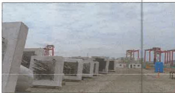
Figura 5.2.3.2. Capiteles prefabricados sobre pilotes de acero
