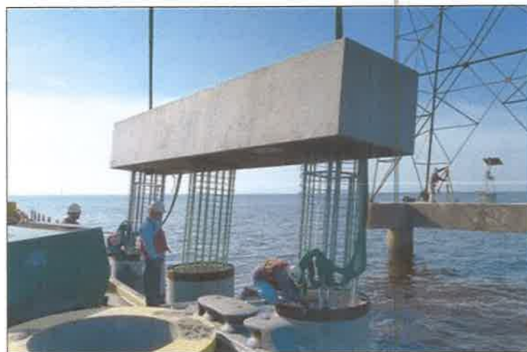
Figura 5.2.2.2. Instalación del cabezal prefabricado para los pilotes
