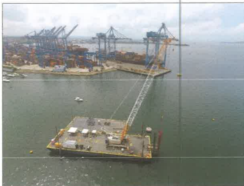
Figura 5.2.2.1. Hincado de pilotes.
