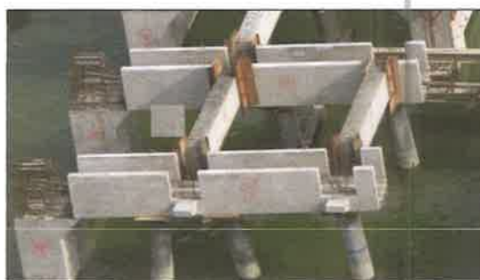
Figura 5.2.3.3. Ejemplo del uso de vigas prefabricadas
