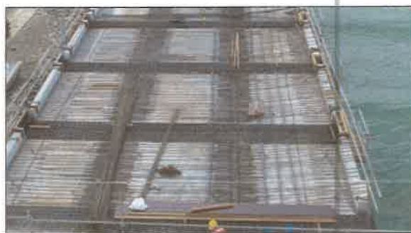
Figura 5.2.3.4. Losas prefabricadas colocadas en el muelle antes de verter concreto
