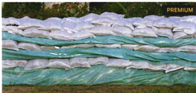
Figura No.1-Ejemplo de muro de sacos de arena y lona para protección.
