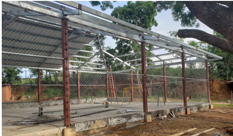
FIGURA 2 – Estado actual del proyecto. Fuente: Equipo Consultor, Junio 2019.
