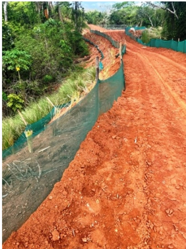
Fotografía 2 Mallas geotextiles y hierba Vetiver protegiendo un talud
