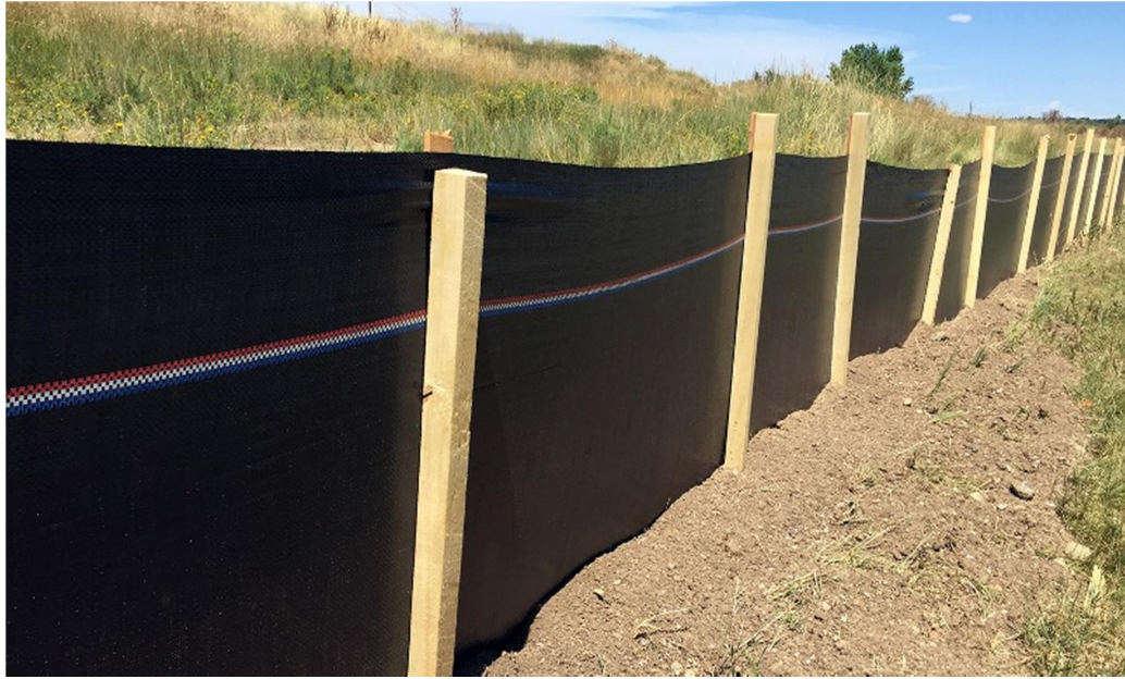
Fotografía 1 Malla para retención de sedimentos ( Silt Fence )
