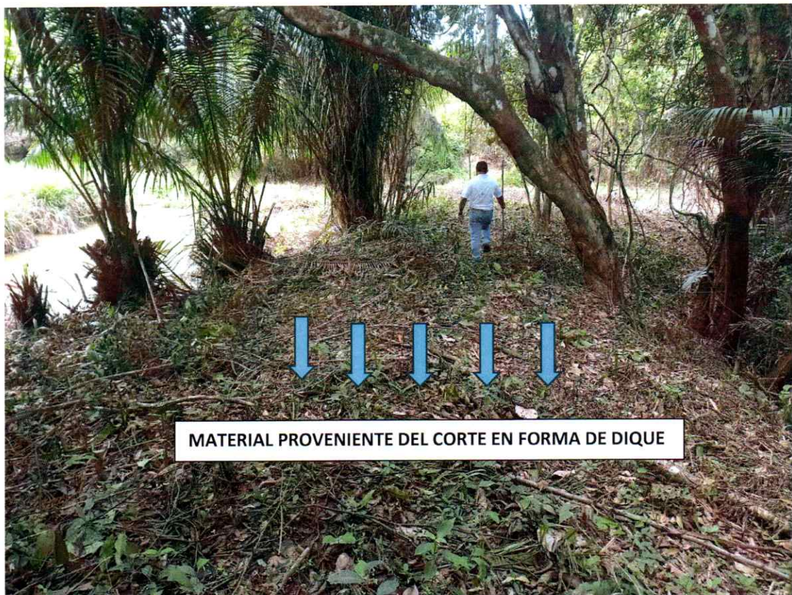
Foto 9. Dique construido con maquinaria para represar agua de lluvia y ser utilizada con fines pecuarios.
