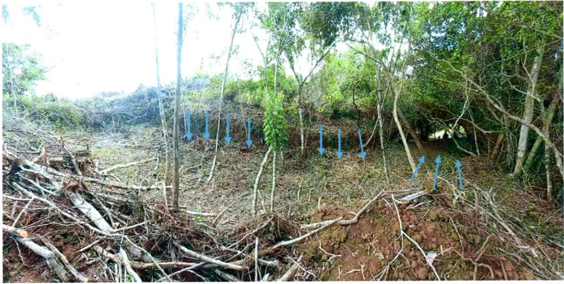
Foto 8. Corte de material que se empujó con máquina para construcción de dique.
