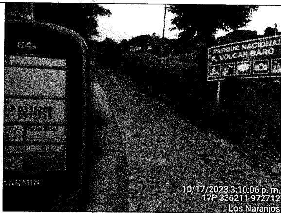
Foto N° 12. Inicio de tramo a rehabilitar con ancho de 8.1m de rodadura actual y cunetas.
