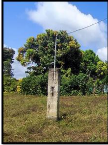
Figura 4-2. Vista de estructura de medidor eléctrico.
