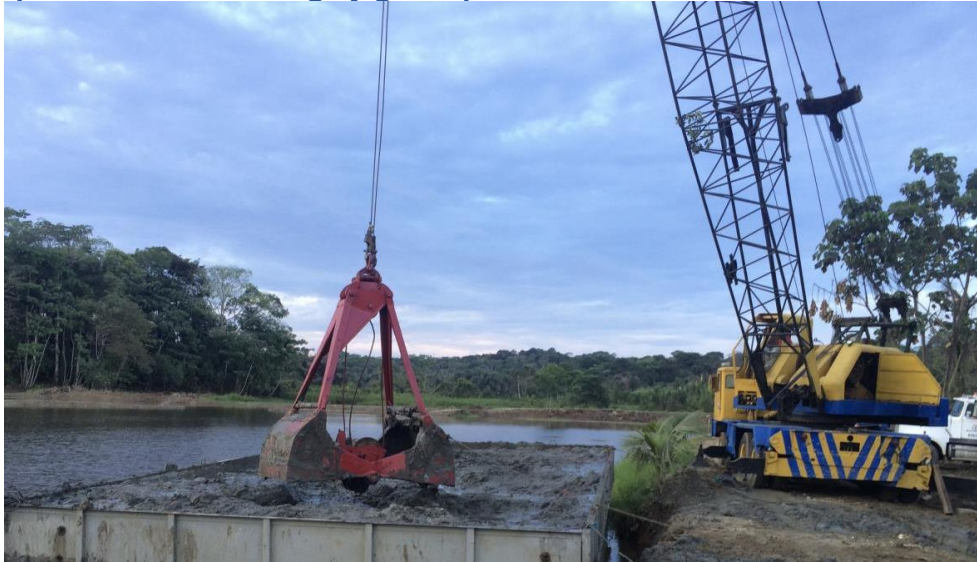
Figura 8. Tipo de barcaza de carga y grúa tipo clamshell a utilizar
