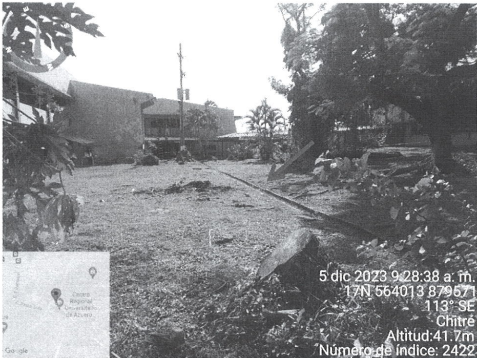
Fig. No. 4: Los árboles talados deberán ser desarraigados a fin de evitar afectaciones a la futura edificación. Se observa cuneta pluvial ubicada a un costado del polígono del proyecto.
