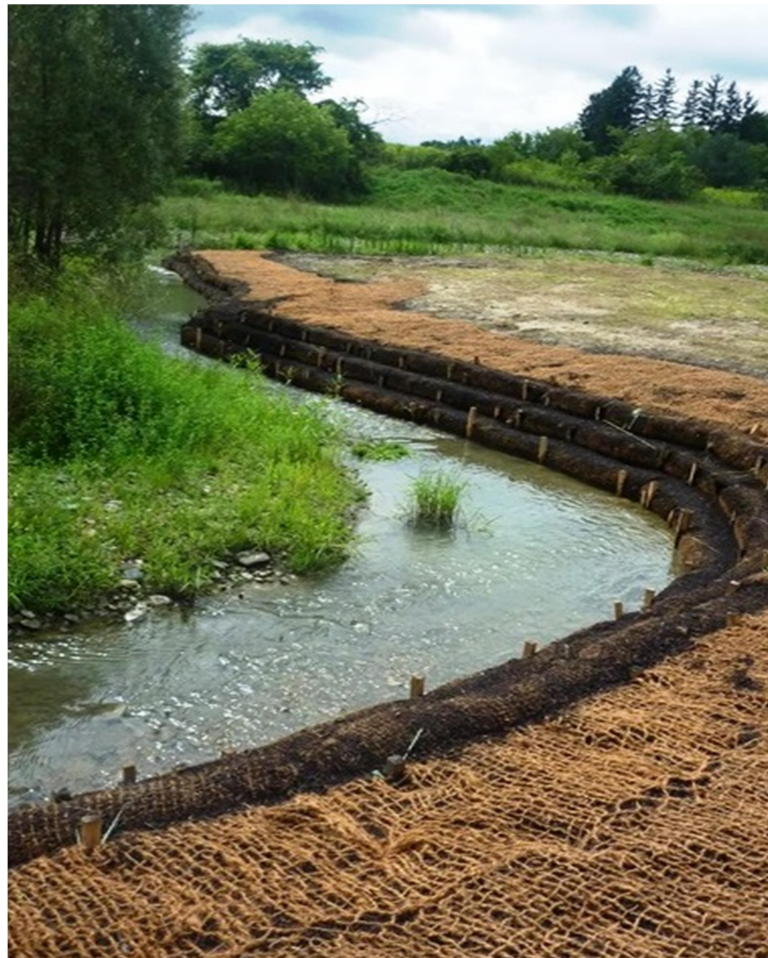
Fotografía 2 Ejemplo de arroyo protegido del aporte de sedimentos con esteras de material orgánico y mallas geotextiles biodegradables
