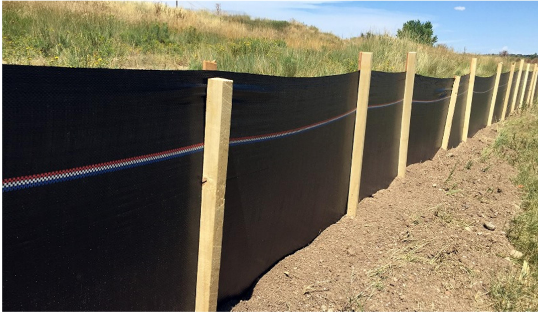
Fotografía 1 Malla para retención de sedimentos ( Silt Fence )
