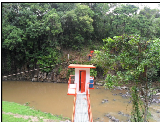
Foto N°10 Estación El Chorro, río Trinidad. Septiembre de 2015.
