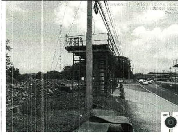
**Fig. 8** La imagen muestra el otro extremo correspondiente al Retorno Vehicular donde observamos que ya se instalaron las columnas de soporte del mismo.
