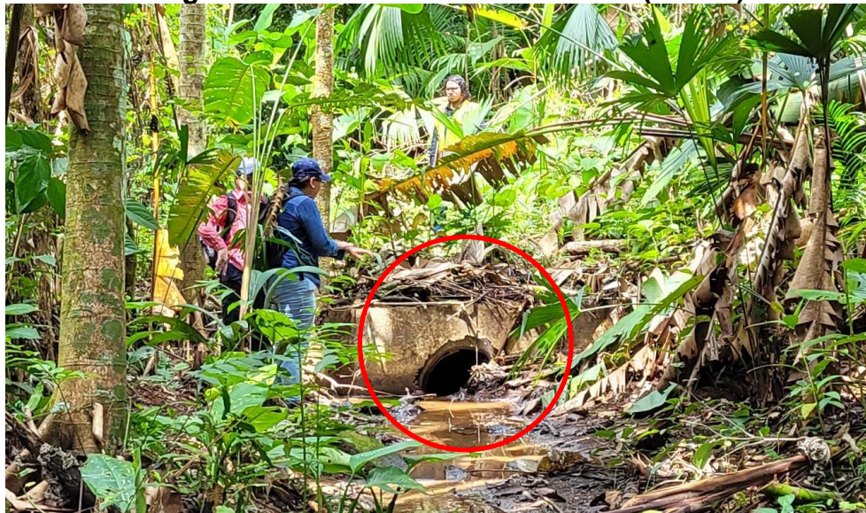
Figura 3-1 Imagen de tubería existente azolvada (Tubo1)
