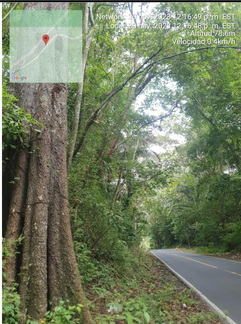
Imagen No.2: Vista del Hura Crepitans propuesto a talar y distanciamiento de servidumbre
