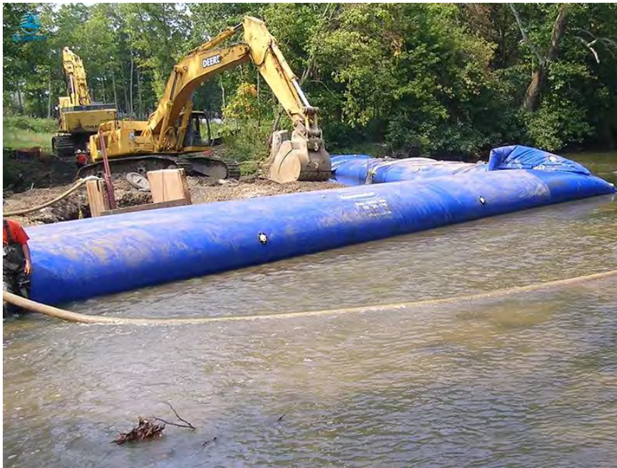
Ataguía para extracción en seco
