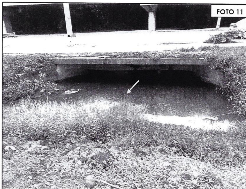
FOTO N°11. CAJÓN PLUVIAL QUE DESALOJA LAS AGUAS DEL ÁREA DE INTERÉS PROPUESTA.
