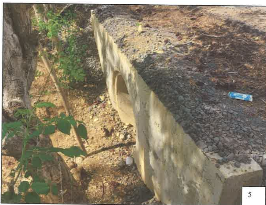
FOTOGRAFÍA 5-6: ESTACION 6K+415 – TUBERIA SENCILLA DE 0.90 M Ø
