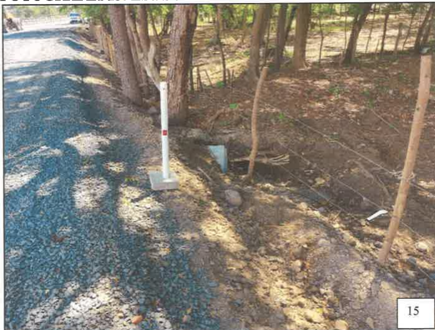
FOTOGRAFÍA 15: ESTACION 7K+928 - TUBERIA DE 0.60 M Ø
