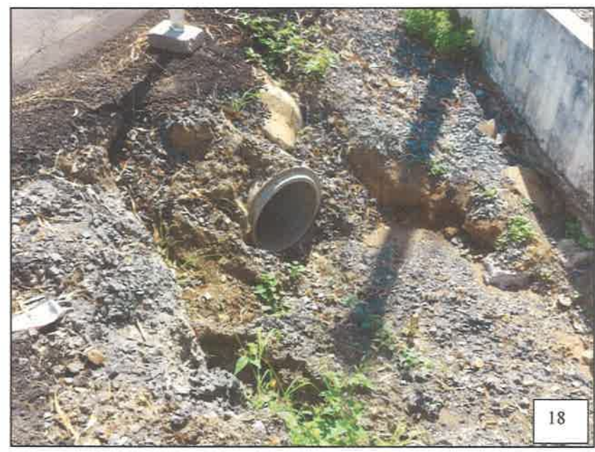
FOTOGRAFÍA 18-19: ESTACIÓN 0K+ 004 – TUBERIA DE 0.45 M Ø
