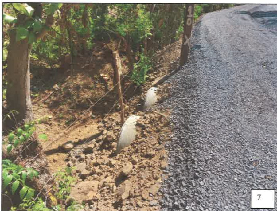
FOTOGRAFÍA 7-8: ESTACIÓN 7K+078, TUBERIA DOBLE 0.75 M Ø
