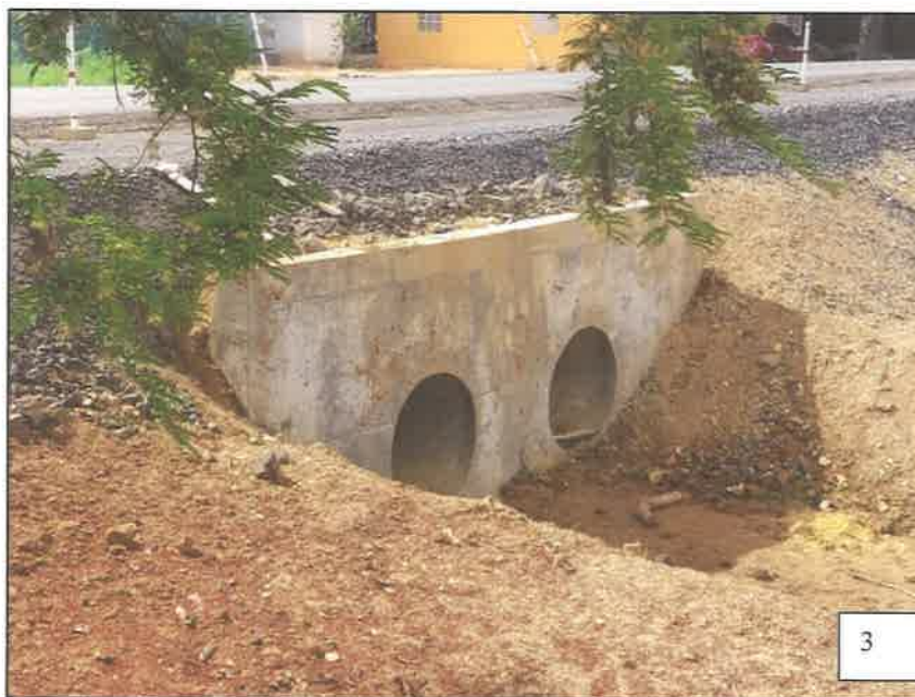
FOTOGRAFÍA 3-4: ESTACIÓN 6K+370 – TUBERÍA DOBLE DE 0.90 M Ø
