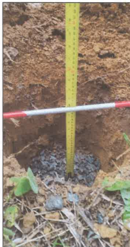
Imagen 1(izq.). Perforación de Hoyos.
