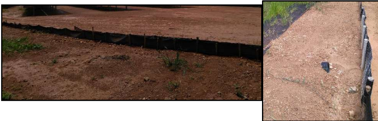
Figura N° 3 Forma de Colocación de Malla Geotextil En El Terreno Como Técnica de Retención de Suelo con Potencial A Erosionarse
