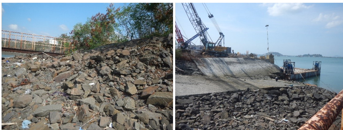
Fotos 6 y 7. Vistas de relleno con rocas sobre la plataforma de mar
