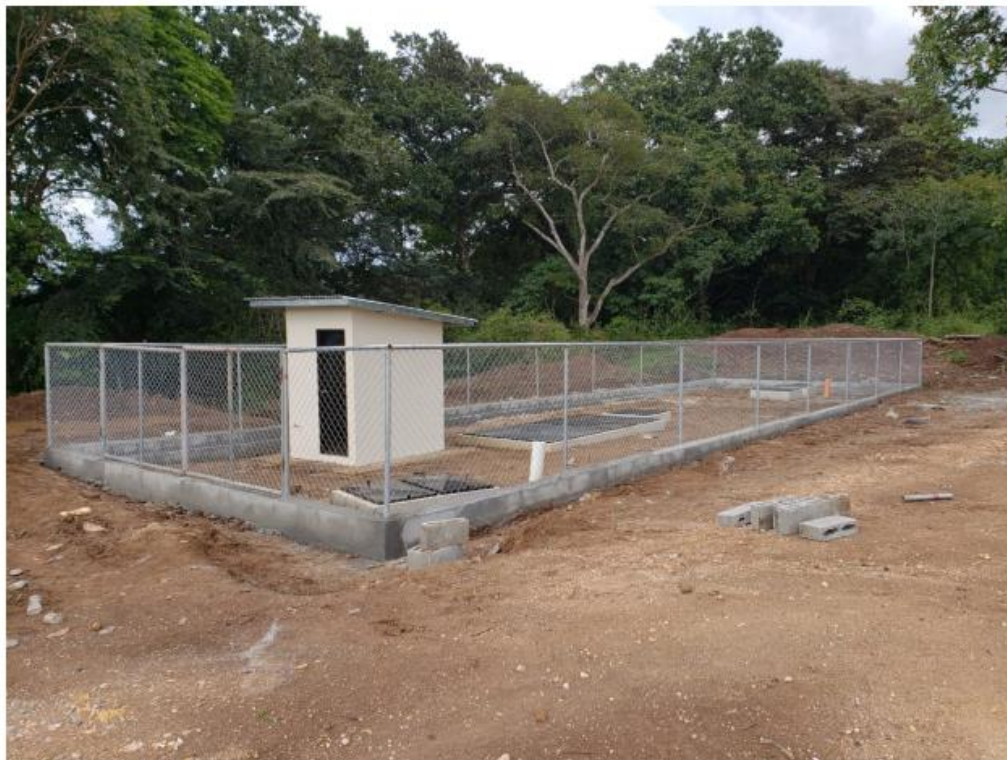
Ejemplo de instalación de cuarto de baño y de la cerca perimetral con malla ciclon.
