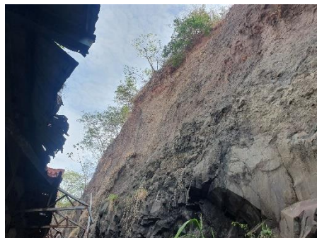
Fotos Nº 5, 6, 7, 8, 9, 10, 11 y 12: Vista general. Tramo prospectado. Se observa construcción moderna y talud en condiciones de deterioro provocado por erosión y deslizamiento de tierra y piedra de la colina colindante.
