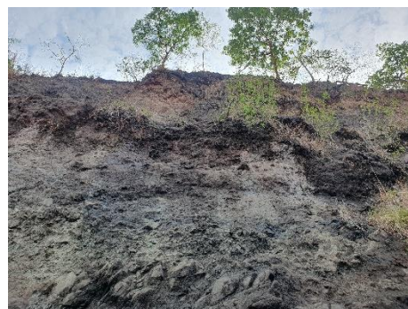
Fotos Nº 5, 6, 7, 8, 9, 10, 11 y 12: Vista general. Tramo prospectado. Se observa construcción moderna y talud en condiciones de deterioro provocado por erosión y deslizamiento de tierra y piedra de la colina colindante.
