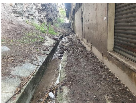
Foto 13, 14, 15, 16, 17, 18 y 19: Vista general. Tramo prospectado. Se observa construcción moderna y talud en condiciones de deterioro provocado por erosión y deslizamiento de tierra y piedra de la colina colindante.
