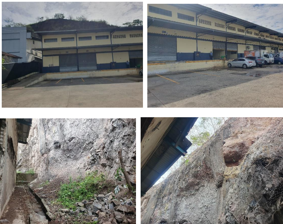
Fotos N°1, 2, 3 y 4: Vista general. Tramo prospectado. Terreno plano cuya parte frontal se observa construcción moderna totalmente pavimentado y en la parte trasera del edificio se aprecia el talud en condiciones de deterioro provocado por erosión y deslizamiento de tierra y piedra de la colina colindante.
