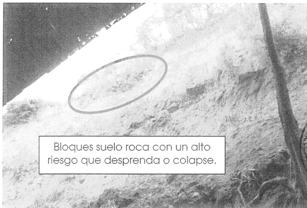
Vistas del material suelo roca que obstruye el desagüe y genera filtración en las instalaciones
