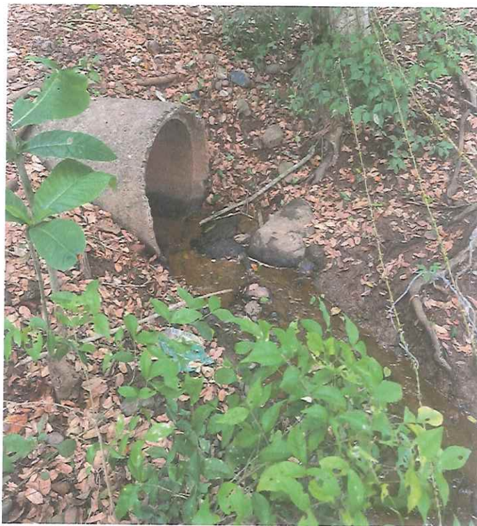
Vista de la alcantarilla de 24" donde descarga el 75% de las aguas pluviales del terreno.
