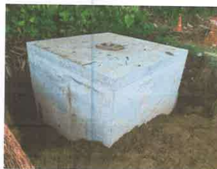
Imagen #4 y 5 cámara de paso subterránea en proceso de construcción y terminada
