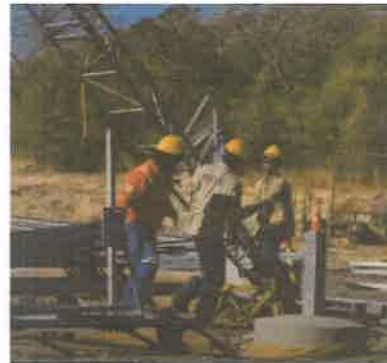
Imagen #8 y 9 Imagen de referencia de armado de torres de transmisión
