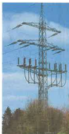
Imagen #8 Imagen de referencia de torre fin de línea con transición de conductor aéreo a cables soterrados
