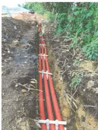
Imagen #1 zanja de ductos para cables
