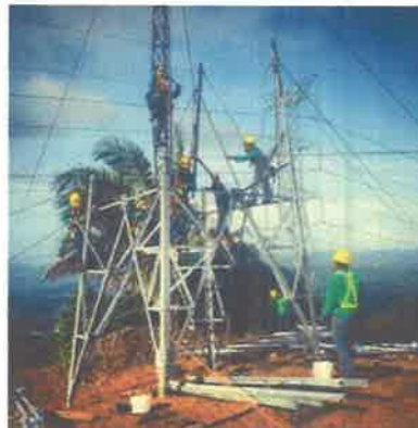
Imagen #10 Imagen de referencia de armado de torres de transmisión
