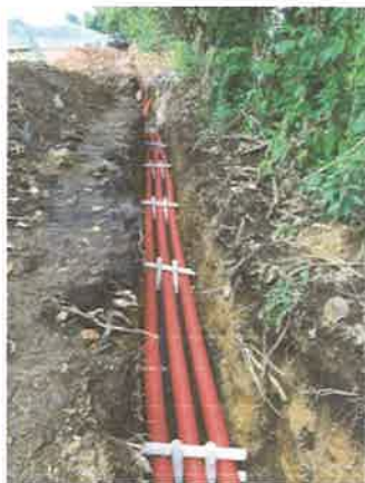
Imagen #1 zanja de ductos para cables
