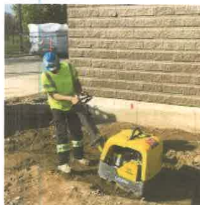
Imagen #2 compactación de relleno.
