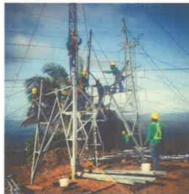
Imagen #10 Imagen de referencia de armado de torres de transmisión
