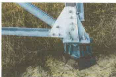
Imagen #9 Fundación de concreto de torres de transmisión.
