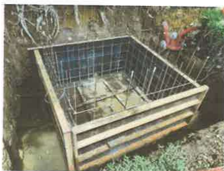
Imagen #4 y 5 cámara de paso subterránea en proceso de construcción y terminada
