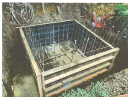
Imagen #4 y 5 cámara de paso subterránea en proceso de construcción y terminada
