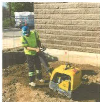
Imagen #2 compactación de relleno.
