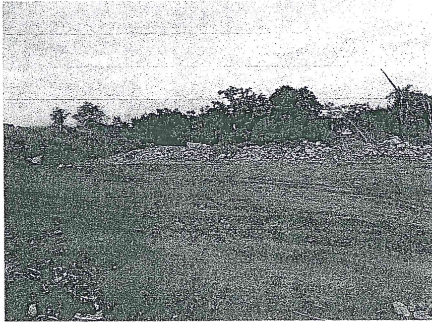
VISTA DEL MATERIAL PETREO COLOCADO COMO MEDIDA DE CONTENCIÓN DEL SUELO Y FILTRO DE AGUA PROCEDENTE DE LAS LLUVIAS EVITANDO LA SEDIMENTACIÓN
