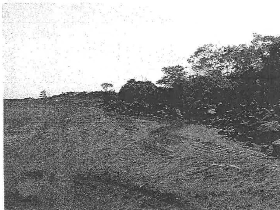
VISTA DE COLOCACIÓN DE MATERIAL PETREO PARA EVITAR EL ARRASTRE DE TIERRA HACIA LAS FUENTES DE AGUAS SUPERFICIALES
