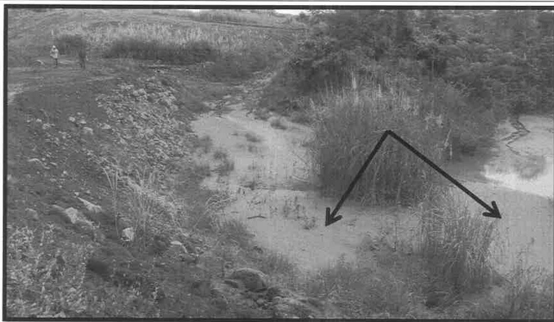
Foto No. 13: En esta imagen se observa la acumulación de lodos, se observa que antes de descargar al río le colocaron roca y tierra donde se filtra y se acumula la cantidad de sedimentos que se visualizan en la imagen.
