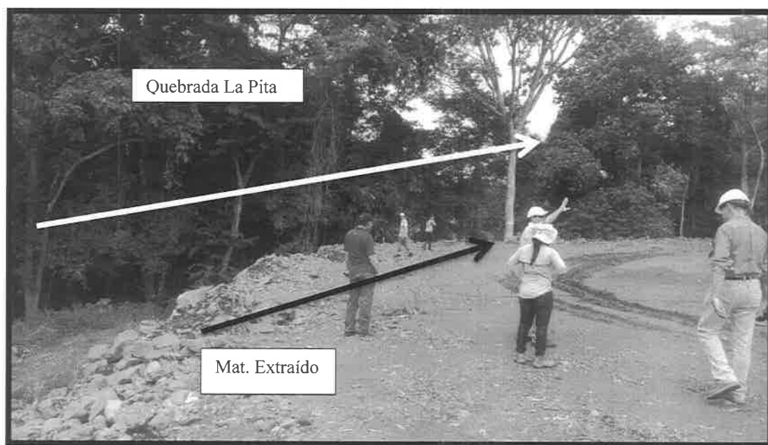
Foto No. 8: El material extraído del cerro mostrado en la foto. No 4, se ha reutilizado a lo largo de las cañadas, quebrada La Pita y Rio Las Lajas
