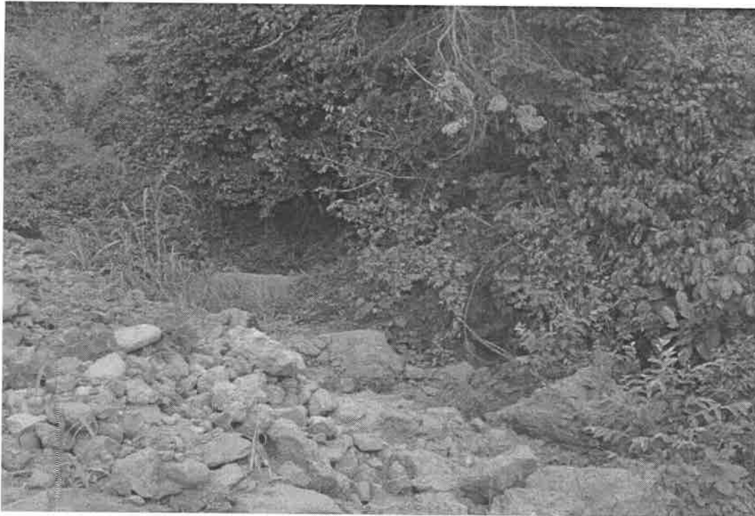
Figura No.2 Material rocoso utilizado como relleno en el área de la cañada No. 2.
