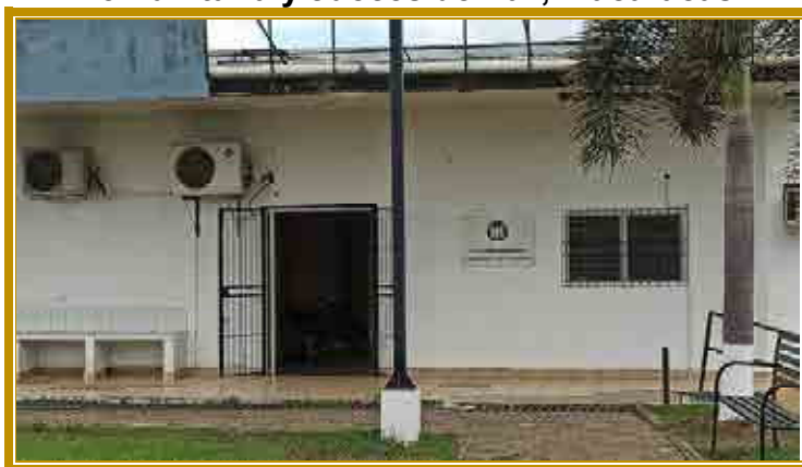
Imagen #94. Local de oficinas del Centro de Mediación Comunitaria y Jueces de Paz, Macaracas.
