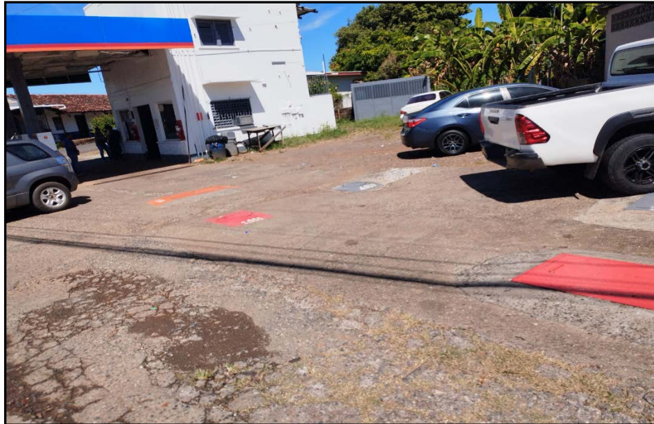
Figura 4-2. Pavimento deteriorado en el área de almacenamiento de la estación.
