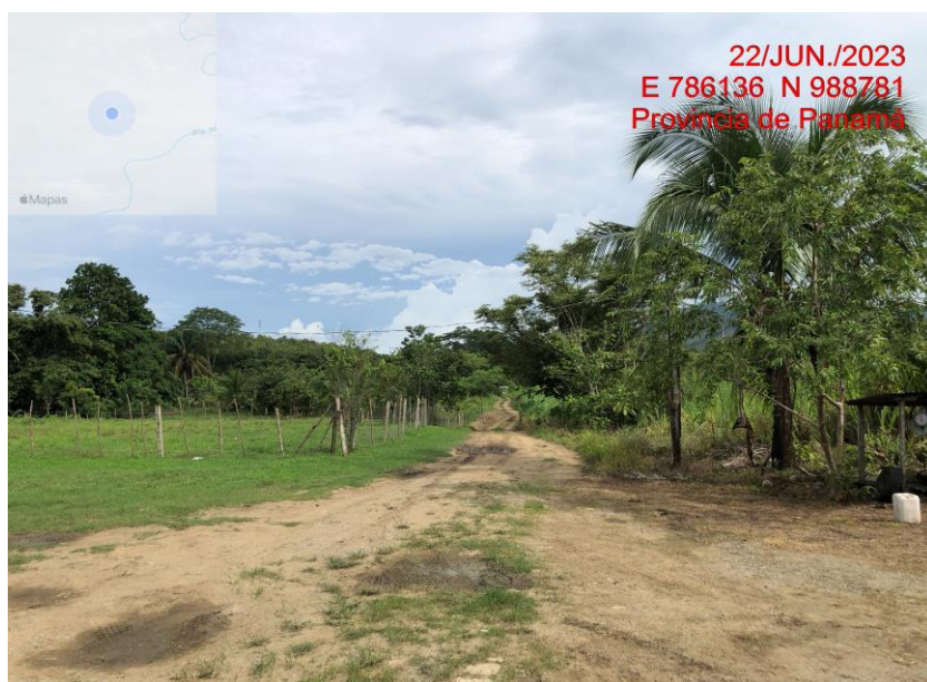
Foto No. 2 Vista de la conformación plana existente en la servidumbre pública.
