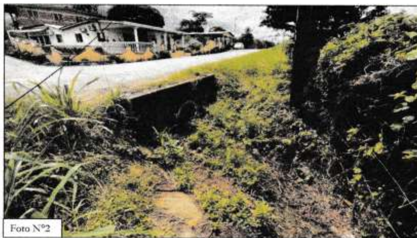
FOTO N°2: Se observa una de las tuberías que desaloja las aguas provenientes del área al Sur del terreno.
