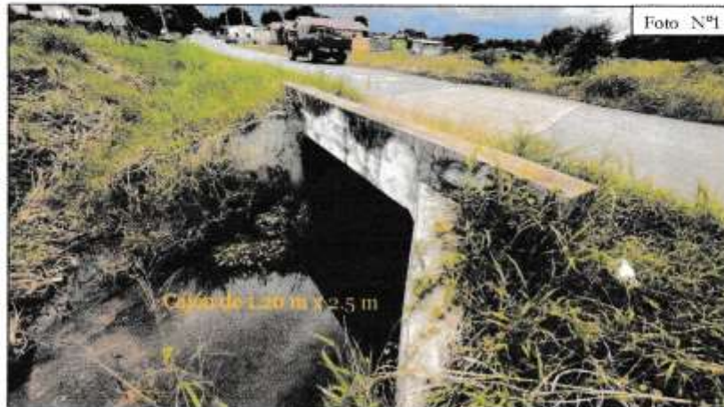
FOTO N°1: Se observa el cajón pluvial que desaloja las aguas provenientes de la zona al Oeste.
