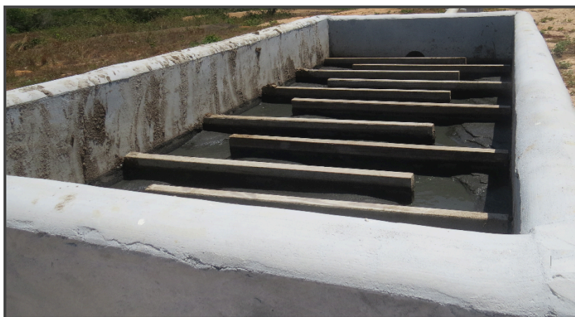
Imagen 4.15. Tanque Sedimentador N°2
