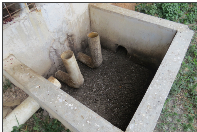
Imagen 4.12. Caja de registro del sistema de tratamiento ubicado en la galera
