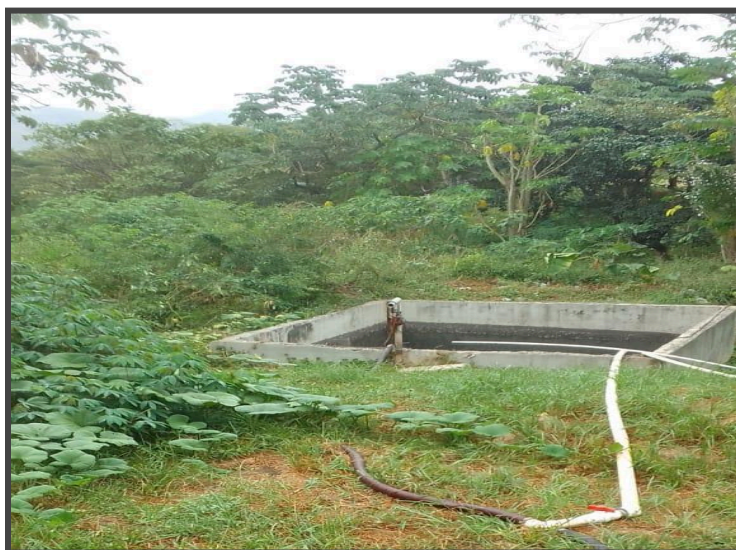
Imagen 4.13. Tanque Sedimentador
