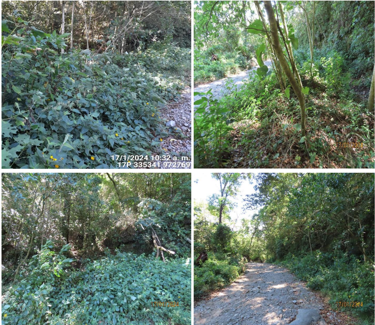
Figura 4. Sección del camino con crecimiento de vegetación que ha acaparado parte de la rodadura existente.
