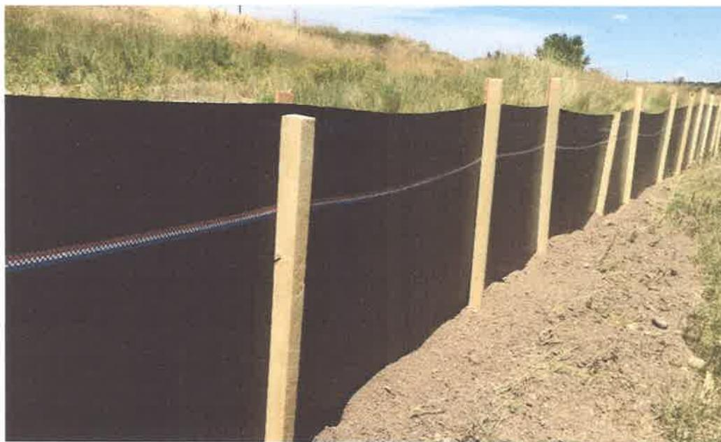
Fotografía 1 Malla para retención de sedimentos (*Silt Fence*)
