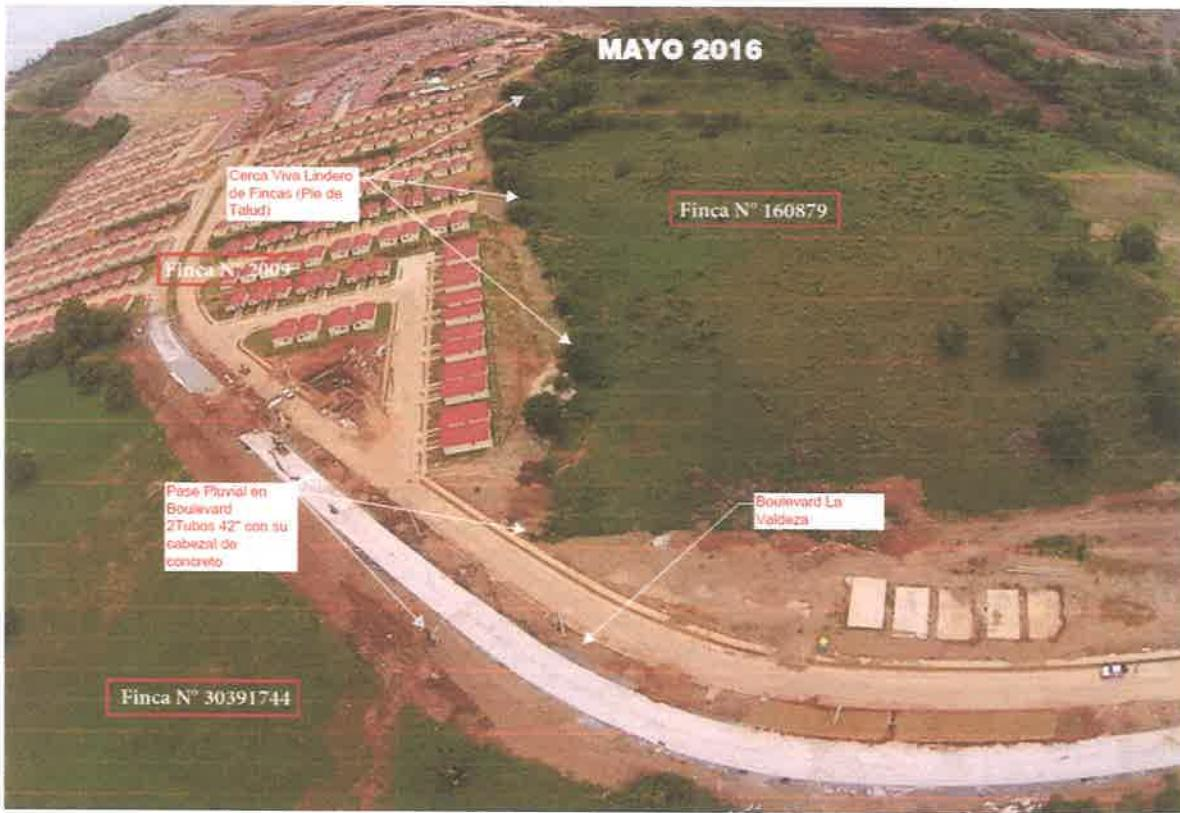
**C.1.3 FOTO N°3.** Esta foto fue tomada mediante un vuelo con dron durante la construcción de la Etapa II de Urb. La Valdeza en la Finca N° 2009 en Mayo del Año 2016 (cuando la Finca N° 160879 aún no pertenecía a Promotora La Valdeza S.A.), y muestra el Pase Pluvial de dos tubos de 42", su Cabezal de concreto construido en el Boulevard la Valdeza para permitir el flujo superficial de aguas pluviales desde la Finca N°160879 hacia la Finca N° 30391744.
