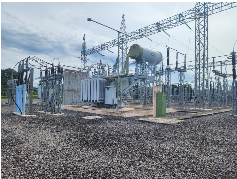
Imagen N°2. Vista de Transformador T3 de 230 kV / 34.5 kV instalado en la subestación.
